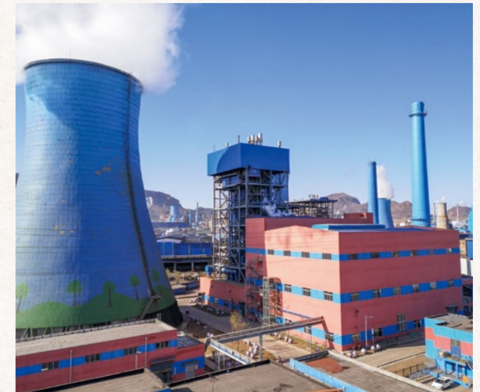
迁安九江线材有限公司 100 兆瓦煤气发电工程
