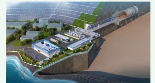
50,000Nm<sup>3</sup> 水平隧洞式岩洞氫儲能系統
