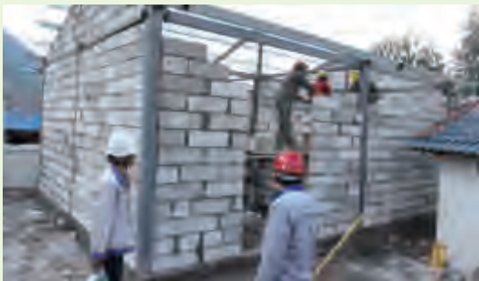
正在施工中的凉山州扶贫安置房
