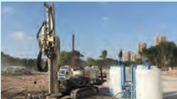
直压注入系统
