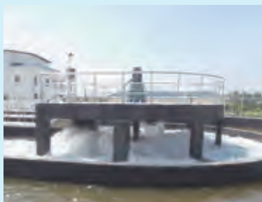
离心自吸混合式倒伞型曝气机安徽宣城应用
