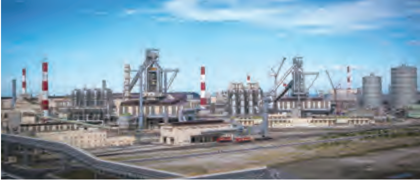
台塑河静钢铁 1 号 2 号高炉
