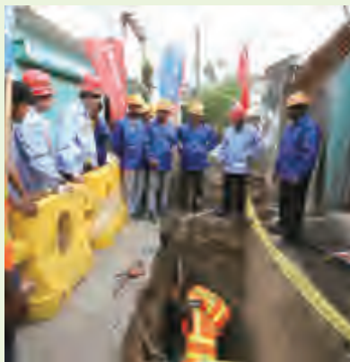
地下管网供水项目施工现场
