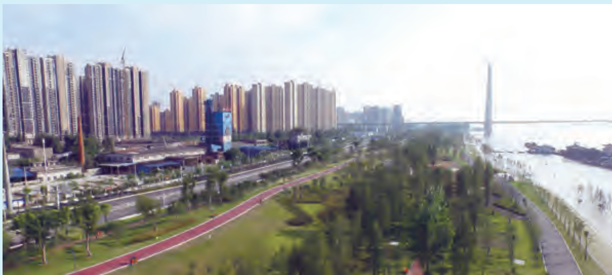
武汉市武青堤江滩综合改造工程
