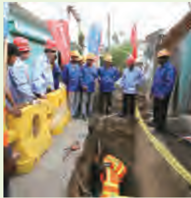
地下管网供水项目施工现场
