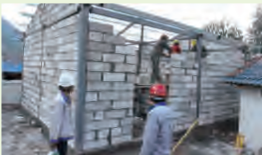
正在施工中的凉山州扶贫安置房
