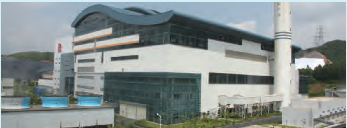
深圳宝安区老虎坑垃圾焚烧发电工程厂区侧面实景图
