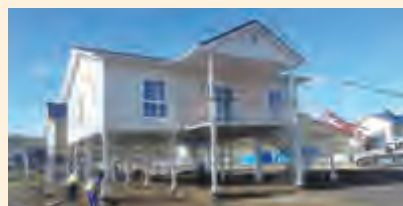
巴布亚新几内亚公务员住房模块化别墅项目
