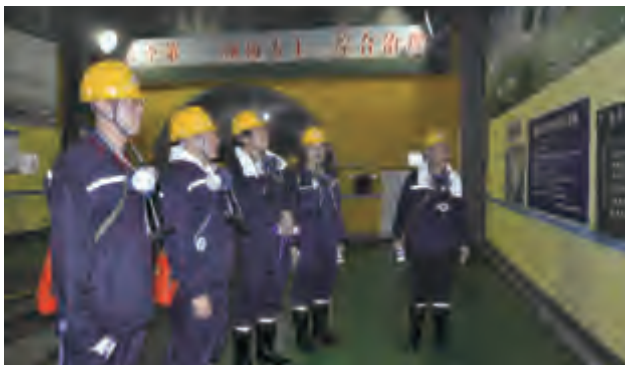
施工现场安全检查
