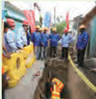
地下管网供水项目施工现场
