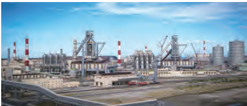
台塑河静钢铁 1 号 2 号高炉
