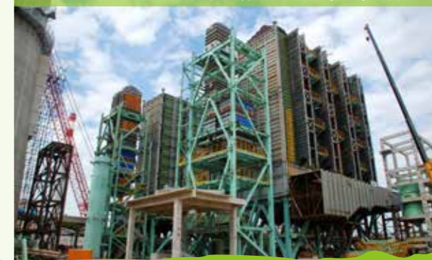
建设中的宝钢湛江钢铁烧结活性炭烟气净化工程 (EP) 项目
