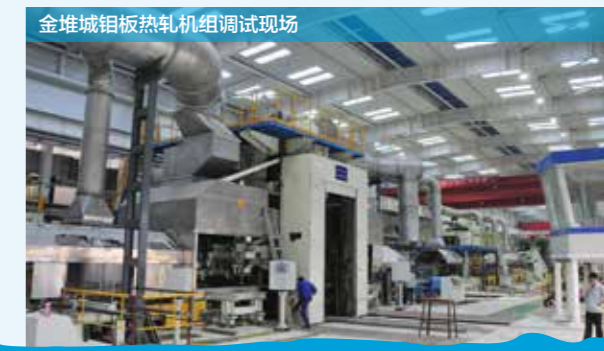
金堆城钨钼板热轧机组调试现场
