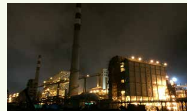
正在运行中的脱硫脱硝装置
