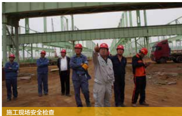
施工现场安全检查
