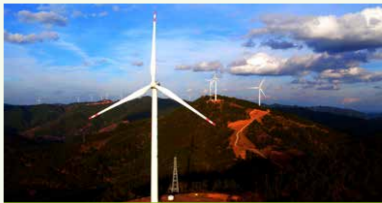
四川凉山州风电场项目
