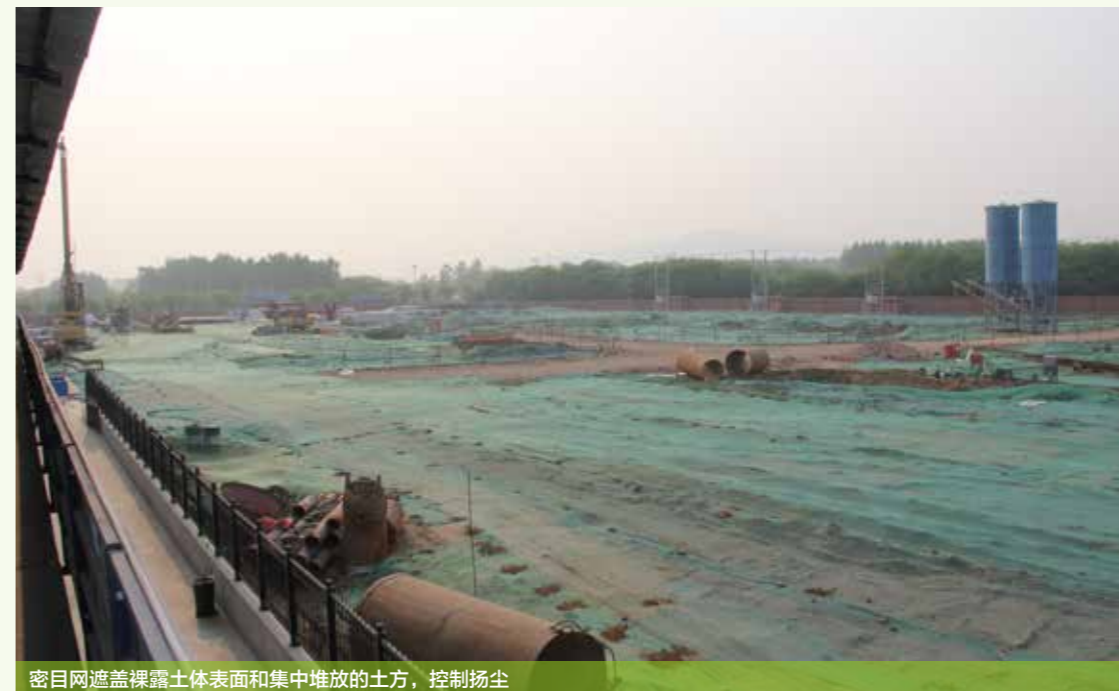
密目网遮盖裸露土体表面和集中堆放的土方，控制扬尘
