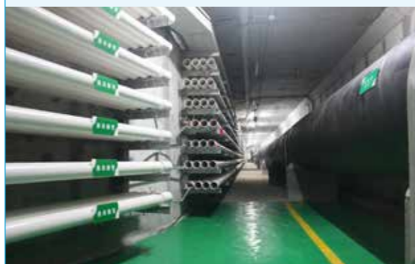
珠海横琴地下综合管廊
