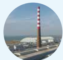
世界上设计规模最大的“双闪”铜冶炼厂 ——广西金川防城港铜冶炼项目
